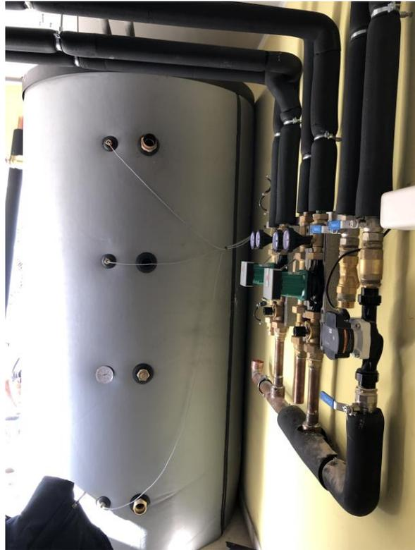
Sustitución y adaptación del sistema hidráulico.
